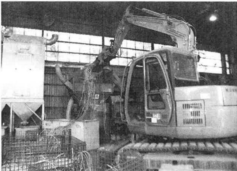
電線のリサイクルライン(秩父回収資源)
